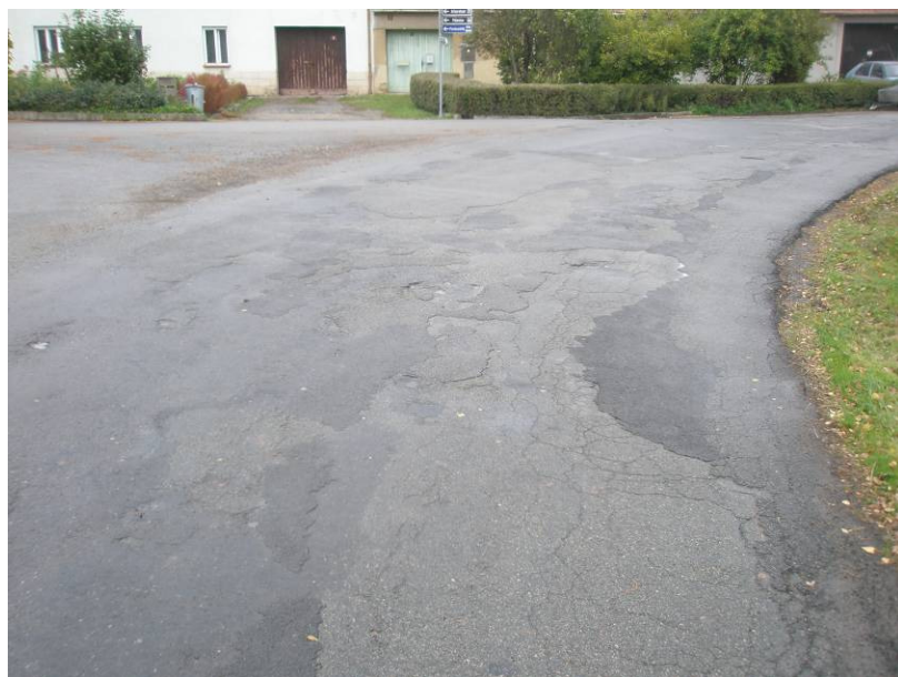
Pohled na úsek (vysprávkky, trhliny, nerovnosti)
