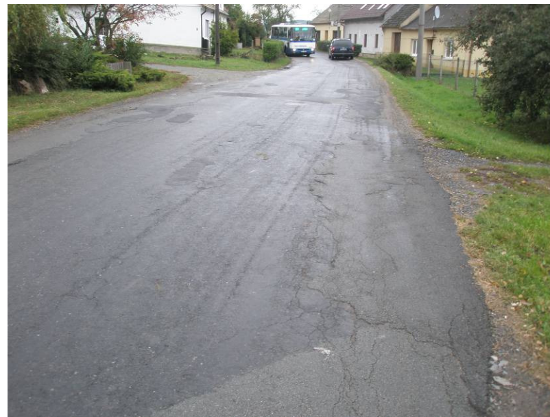
Pohled na úsek (vysprávkky, trhliny, nerovnosti)
